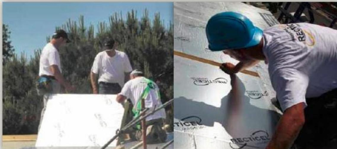
En commençant par le bas du versant, les panneaux prennent appui sur la butée de bas de rampant et se posent à joints croisés.
